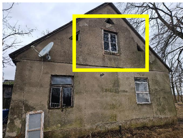
Ēkas fasāde ar dzīvokļa logiem
